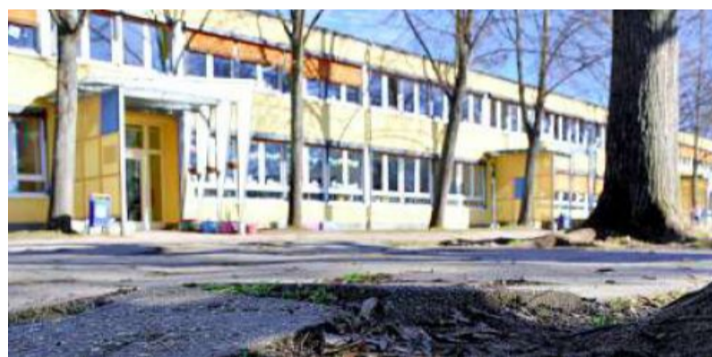
Angehobene Gehwegplatten, Löcher im Asphalt: Die Schüler haben genug von ihrem maroden Schulhof.
