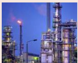
In Anlagen wie dieser wird Rohöl verarbeitet. FOTO: DPA
