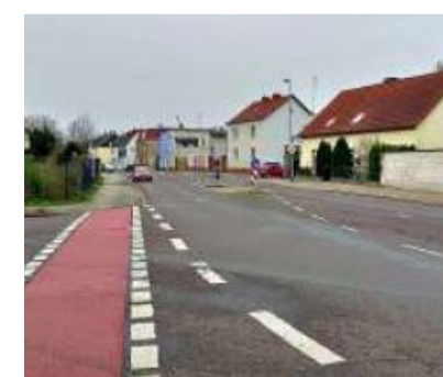
Der Weizengrund muss wegen SWM-Bauarbeiten komplett gesperrt werden. FOTO: LENA BELLON
